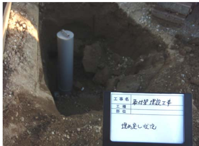
取付管の埋め戻し状況
