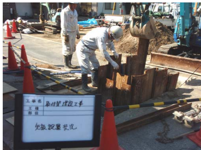
矢板設置状況
