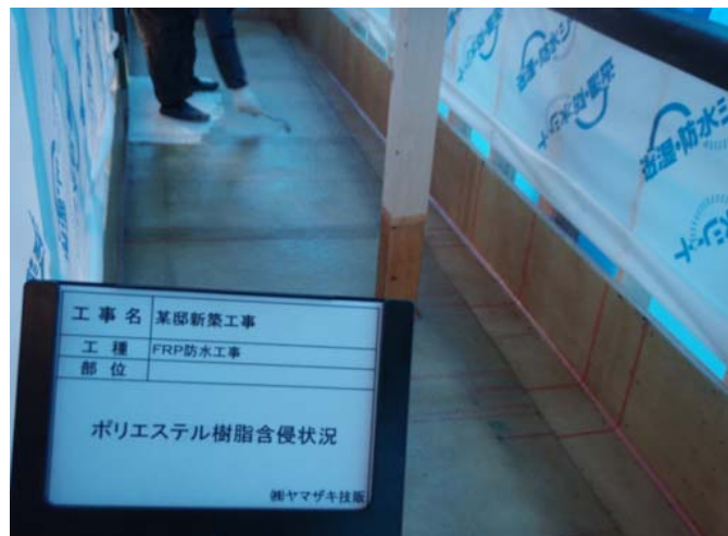
ベランダ、FRP防水 ブルーシート養生内での作業状況 少し薄暗くても大丈夫
