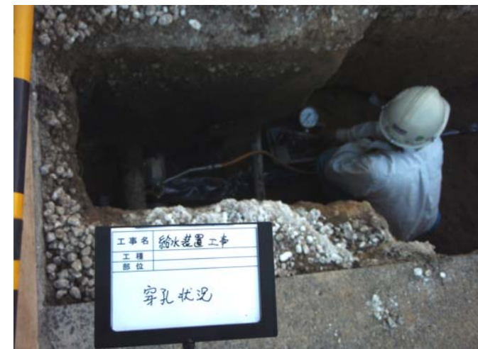
給水装置工事
