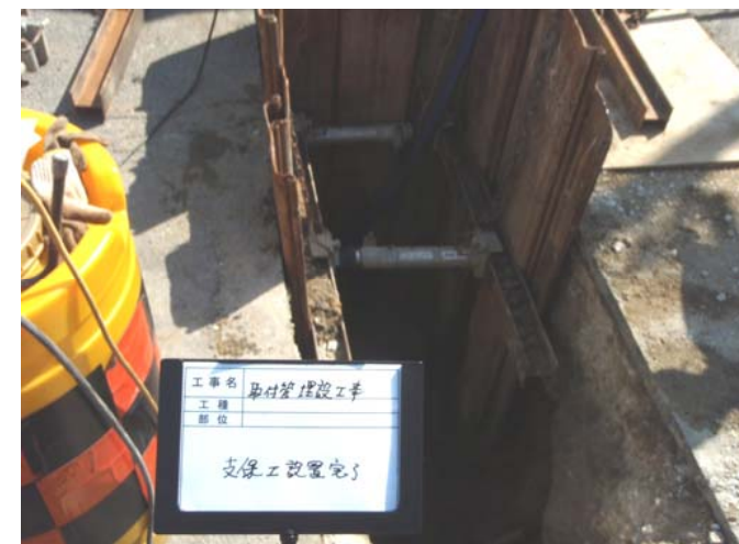
支保工設置完了
